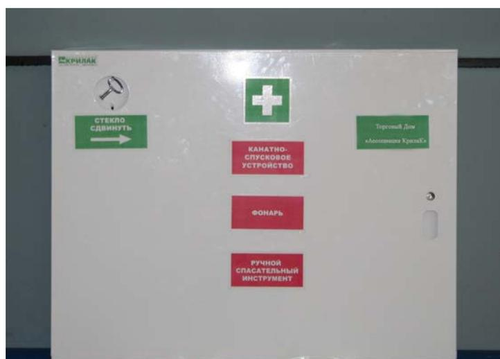
Внешний вид «МИПШ», состоящего из одного модуля (канатно-спусковое устройство, ручной спасательный инструмент, фонарь)
